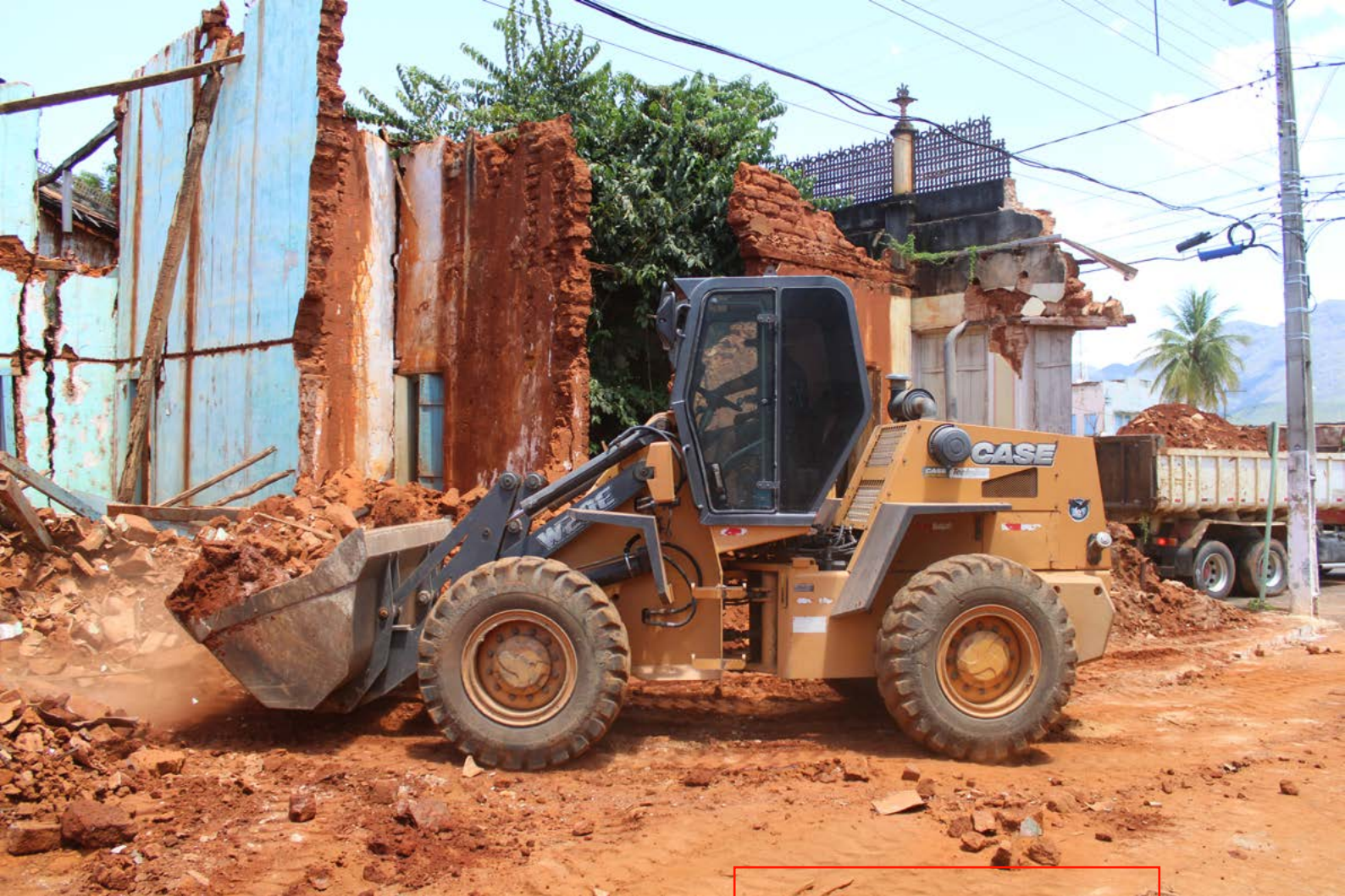
Fig. 03: Trator recolhendo o entulho da demolição, 2022. Fonte: Arquivo do Autor
